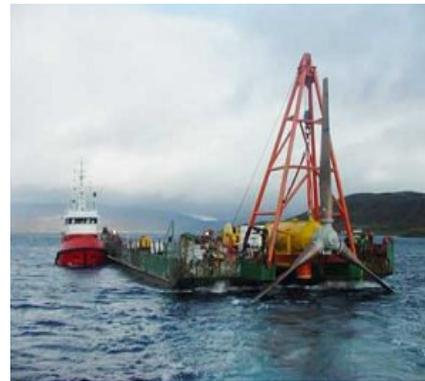
Figure 17. Tidal Stream Turbine[58]
